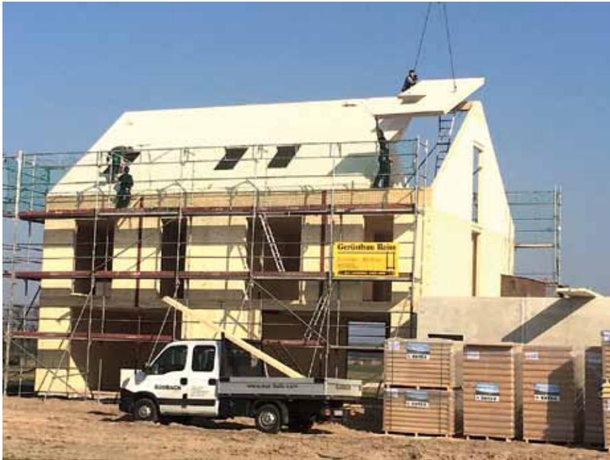
Dank der vorgefertigten, passgenauen Massivholzbauteile ist das Haus rasch aufgestellt und das Dach geschlossen.
