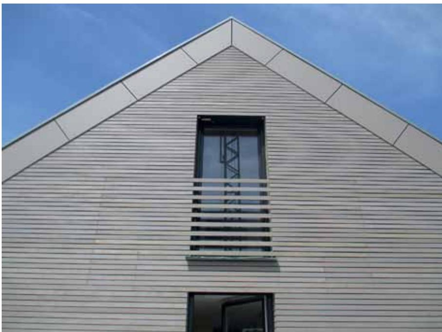
Die Giebel sind mit einer Rhombusschalung bekleidet. Am bodentiefen Fenster im Obergeschoss bildet die Schalung auch die Absturzsicherung.
