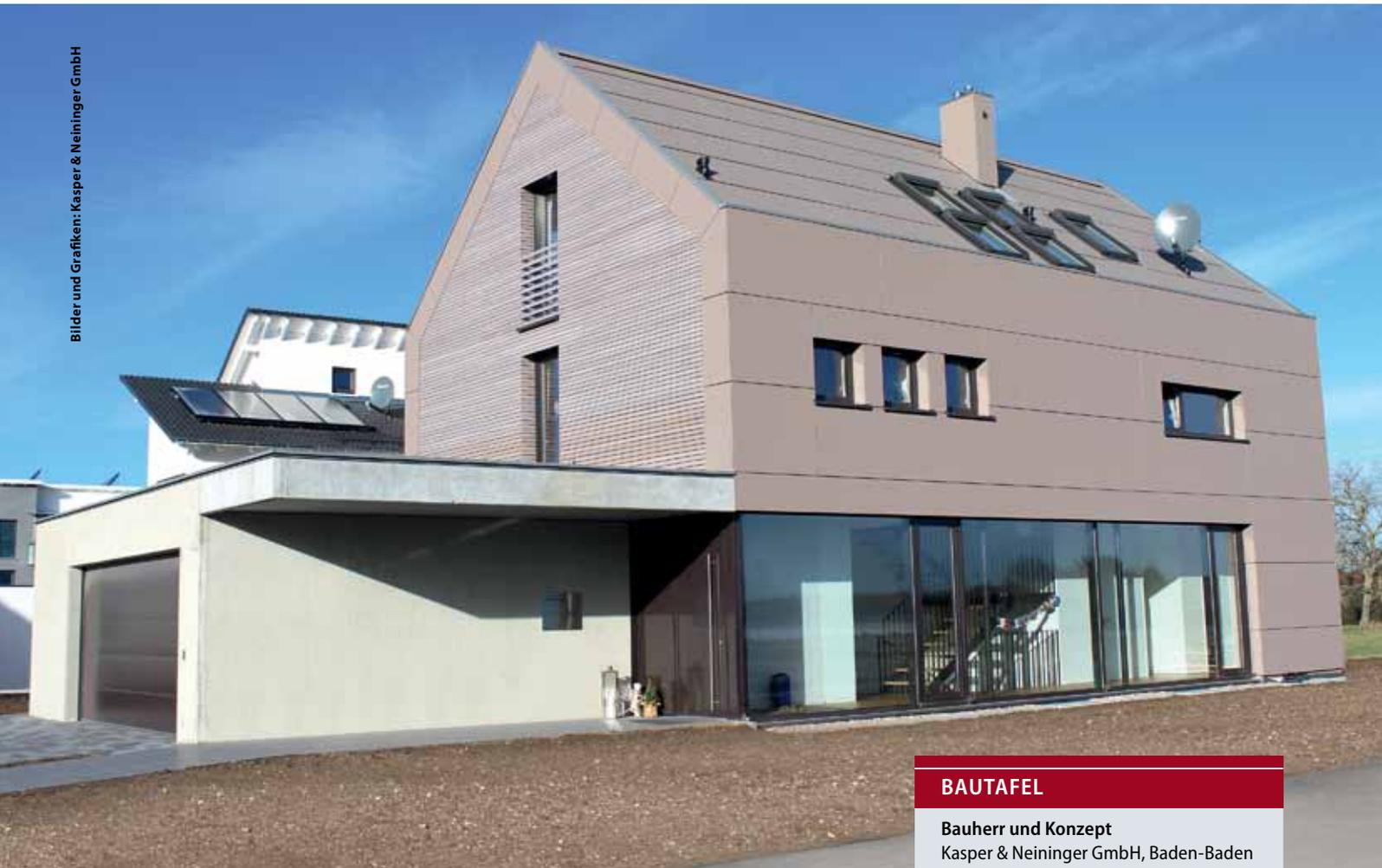
Der Prototyp eines schlüsselfertigen Massivholzhauses kommt mit einer modernen Fassade daher, die auch über das Dach hinweggeführt wird.
